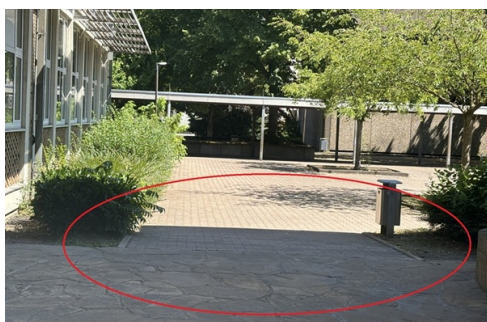
Abb. 20: Rampe im Hofübergang [1, ful]
